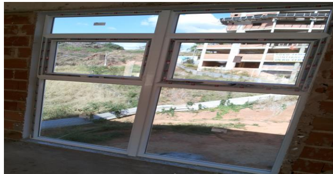
Janela de PVC instalada
