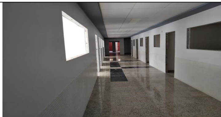
Pavimento 3 com os vãos dos visores
