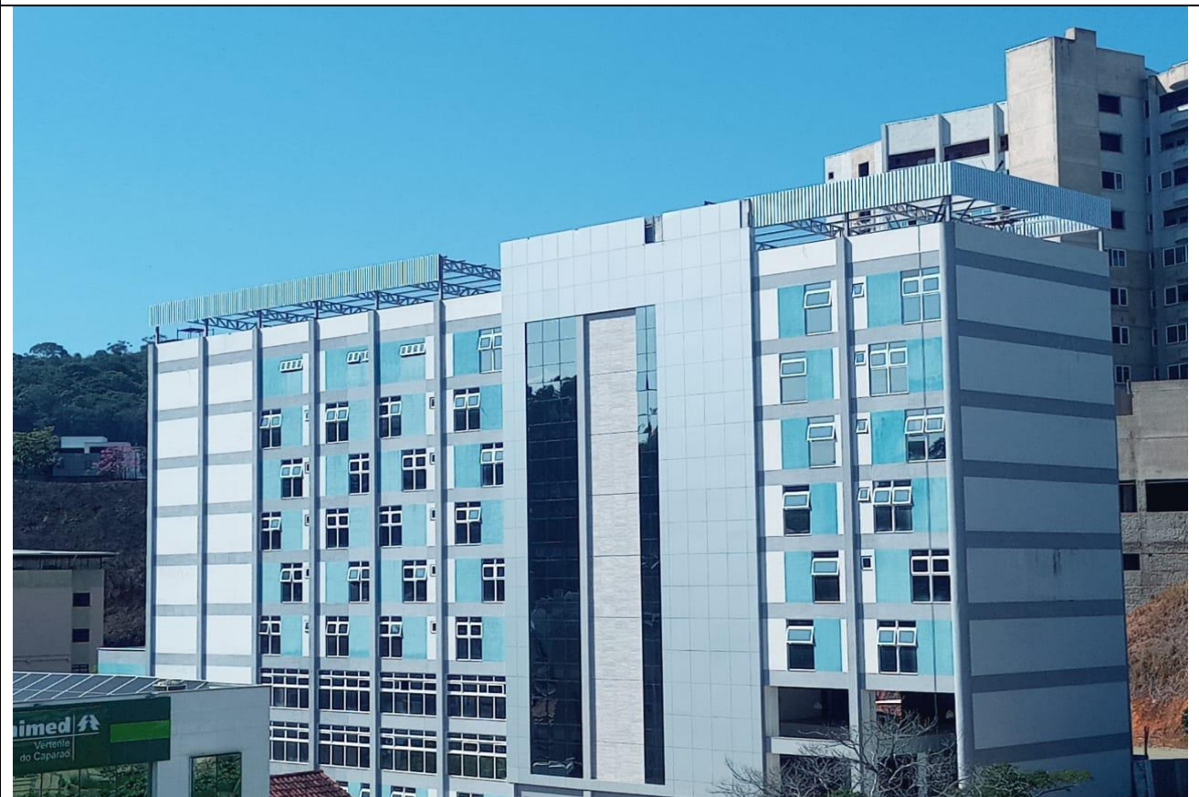
Fachada frontal - Oeste
