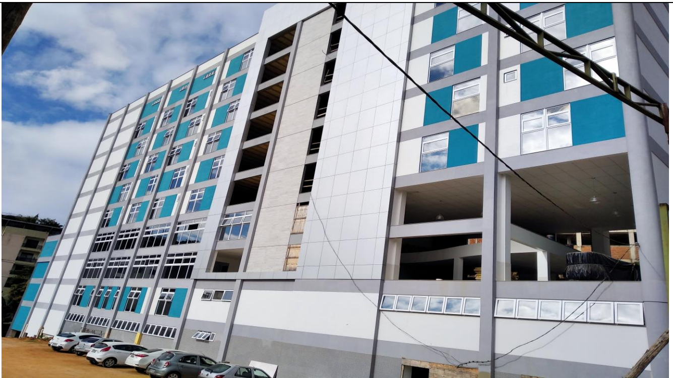
Fachada frontal - Oeste
