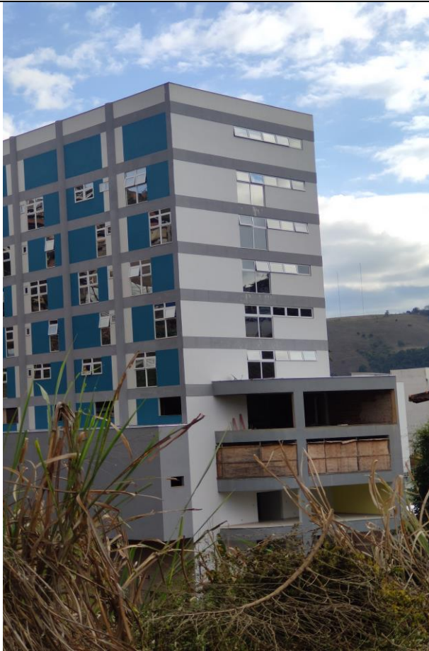
Vista da fachada leste(fundos)
