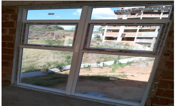
Janela de PVC instalada
